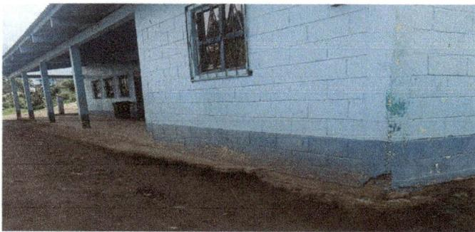
Foto 5: Reparación de banquetas de concreto
